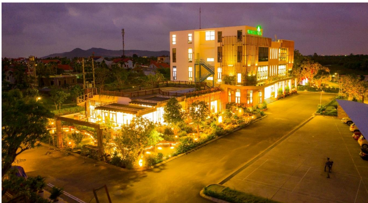
Ảnh 7. Hệ thống điện năng sử dụng nguồn năng lượng tái tạo điện năng lượng mặt trời NCK
