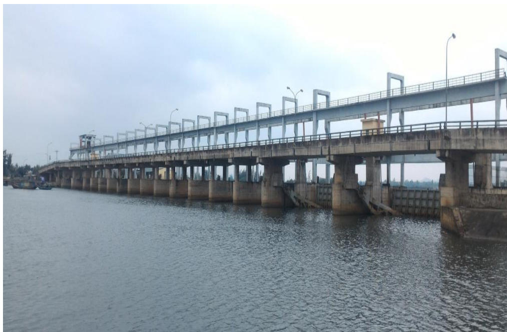
Photo 3.7: Do Diem saltwater barrier on the Nghen River (đập ngăn mặn Đò Diệm)
