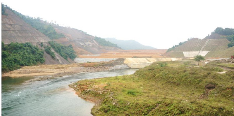
Upstream view from the Ngan Truoi bridge
